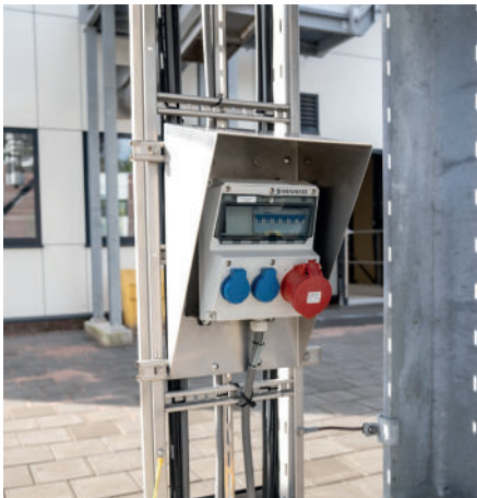
AMAXX® combinatie van MENNEKES voor servicedoeleinden onder de slibsilos.
