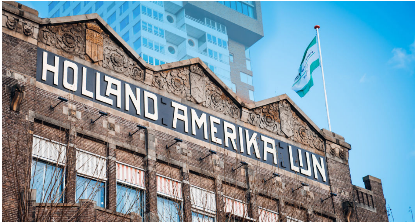
Meyer Highlines met wandarm als wall washers
