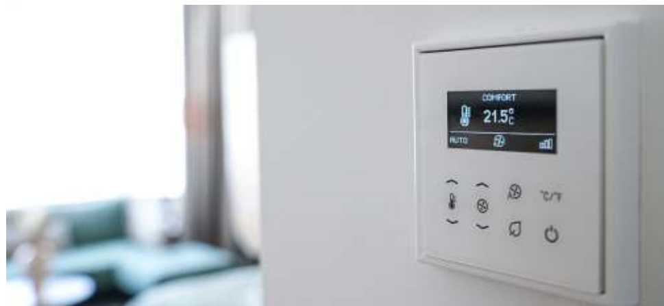
Ook de Fancoil thermostaat helpt mee aan een goed geregisseerde temperatuursturing.
